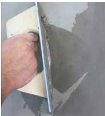
No aplicar capas de más de 1 mm de espesor para los microcementos Microbase y Microfino. Se recomienda un espesor total de sistema de 1 a 3 mm.
